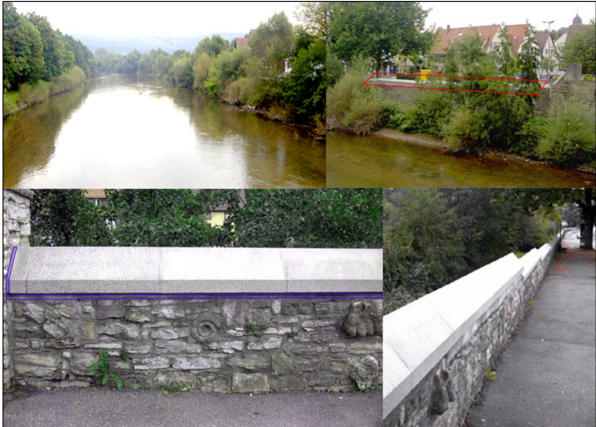
Abb. 48: Überblick über Enz und öffentliche Hochwasserschutzbauten in Mühlacker-Dürrmenz.
