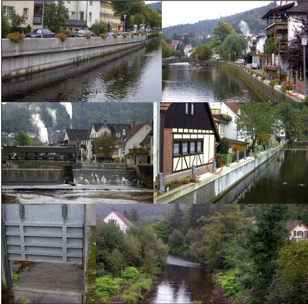
Abb. 49: Öffentliche Hochwasserschutzbauten in der Stadt Neuenbürg. Die beiden oberen Bilder zeigen stromaufwärts blickend die Ufer der Enz in der Stadtmitte. Im linken Bild lässt sich gut erkennen, wie nach dem Hochwasser von 1993 die Betonwand erhöht wurde (oberhalb der dunklen Linie). Die Bilder oben rechts sowie mitte rechts zeigen die am anderen Enzufer nach 1993 installierten Spundwände. In die – durch einen roten Kreis gekennzeichneten – Streben lassen sich im Hochwasserfall mobile Wände einsetzen und verankern. Das Bild in der Mitte links zeigt eines der insgesamt sieben in der Gemarkung Neuenbürg liegenden Wehre. Diese bestehen etwa seit 1960 und werden zur Stromerzeugung genutzt, wobei sie z.B. bei Hochwasser geöffnet werden können (Bild unten links). Das Bild unten rechts zeigt die Enz etwa 100 Meter weiter stromabwärts am Ortsausgang. Hier bestehen noch keinerlei öffentliche Hochwasserschutzbauten, diese Bereiche werden bei erhöhter Wasserführung ständig überschwemmt. Quelle: Eigene Photographie, September 2002
