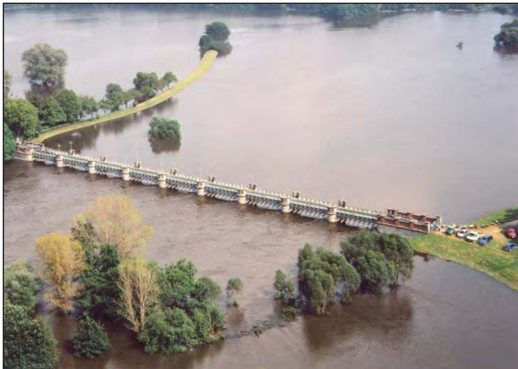
Abb. 19: Geöffnetes Pretziener Wehr beim Hochwasser im August 2002 (Foto: M. Simon)
